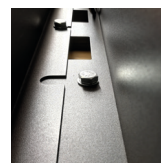
Vorbereitung für Bodenverankerung
